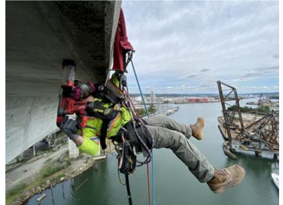
Sự ổn định ban đầu của cầu cao đã được Kraemer North America hoàn thành vào cuối năm 2020, họ cũng sẽ lãnh đạo công việc giai đoạn 2 (phục hồi chức năng).
